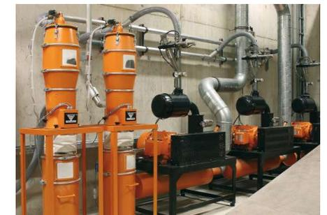
Vakuumpumpen mit 11 kW und Sa 3 Sicherheitsfilter mit 60l Auffangbehälter
