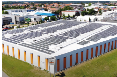
Werk II: Trocknerbau in Göbrichen
