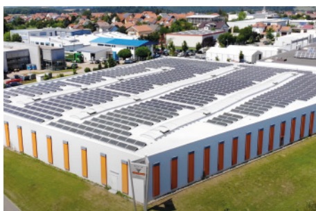
Usine de fabrication II : Fabrication des dessiccateurs à Göbrichen
