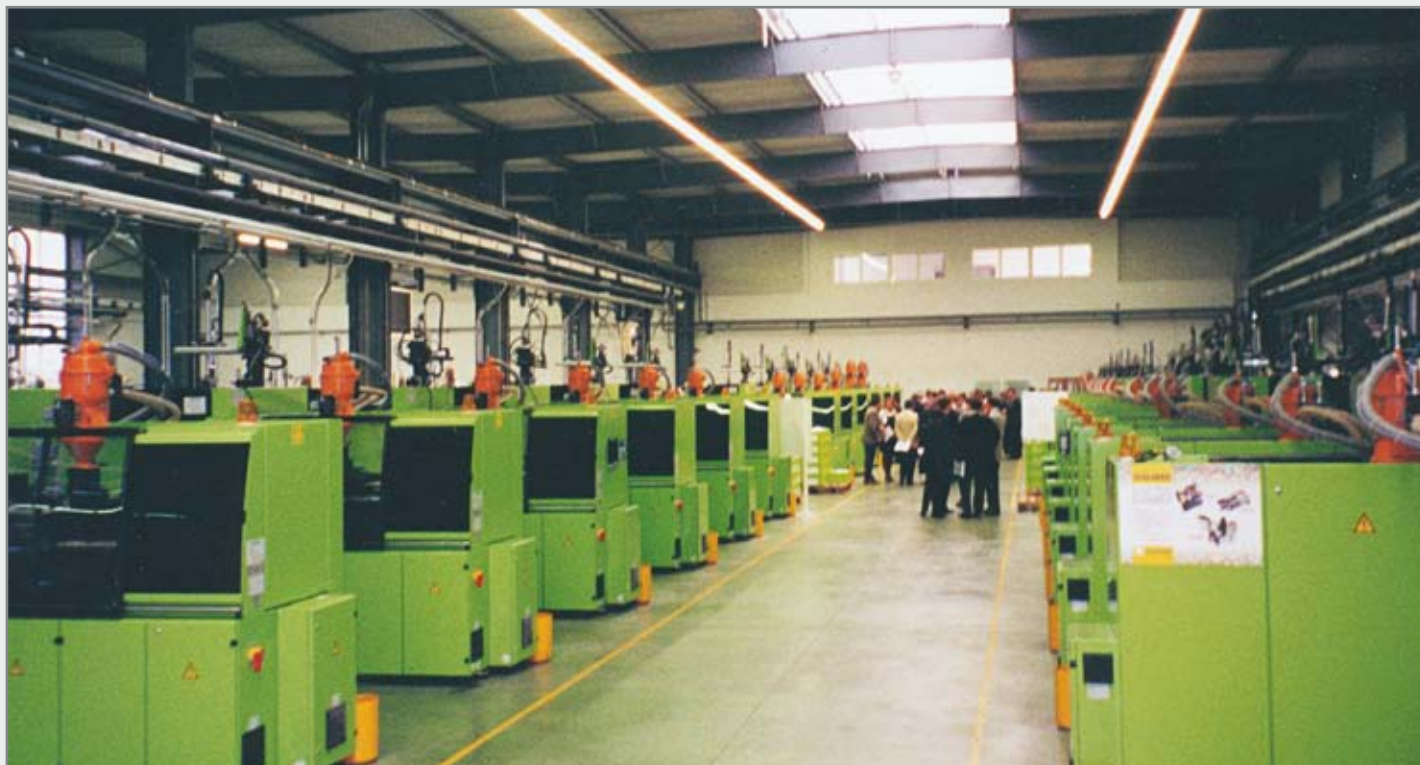
Alimentation centralisée de 90 presses
