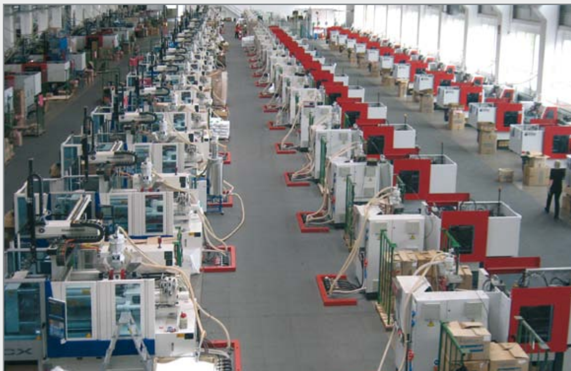
Alimentation centralisée d'un fabricant de jouets avec séparateurs et système de séchage, avec mise en teinte blanche, destinés à alimenter 108 presses.
