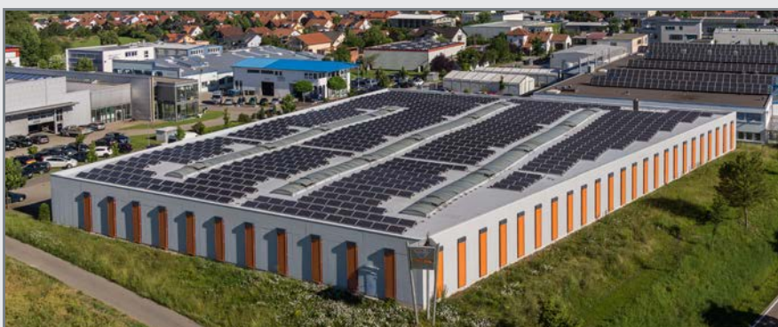
Usine de fabrication II : Fabrication des dessiccateurs à Göbrichen
