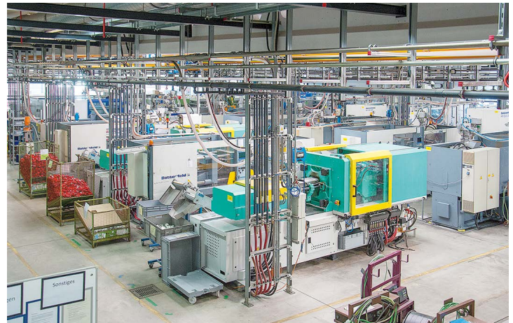
Kompakte Spritzgießhalle: Bei Walther arbeiten Spritzgießmaschinen von Arburg und Battenfeld, die meisten versorgt über ein Motan-Materialmanagement.
