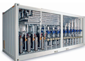
Kompakter Container mit mehrkreisig ausgelegter Temperier- und Kühltechnik in den Medien Öl und Wasser
