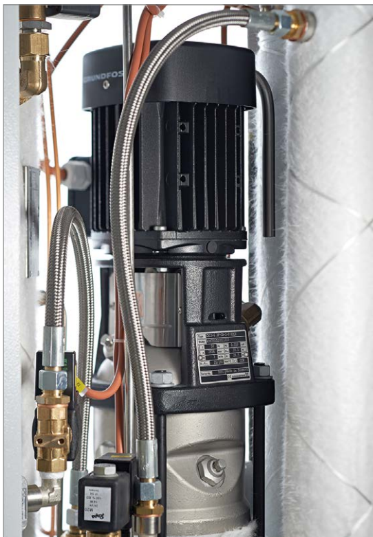
Mehrstufige Kreiselpumpen bieten einen effektiven Wirkungsgrad
