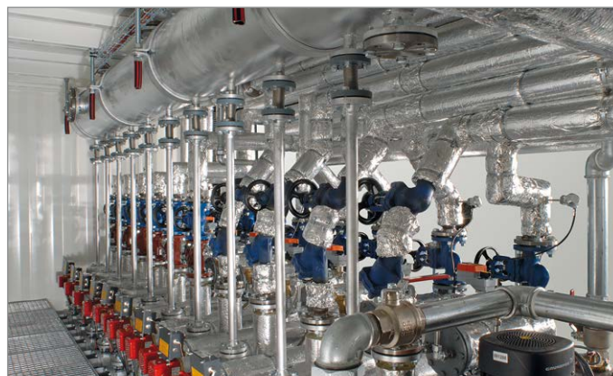
Innenansicht eines Containers
